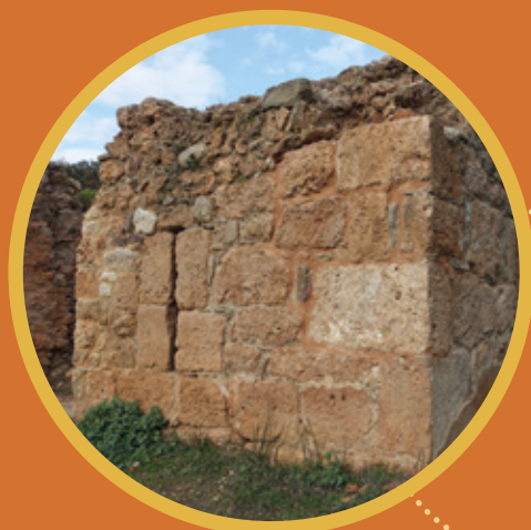
► Ruines du bâtiment fortifié
