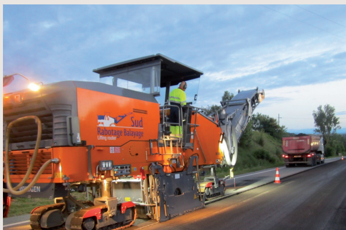
Le renforcement et la mise en sécurité de la rocade Sud de Carcassonne se sont poursuivis à l'automne 2019.
