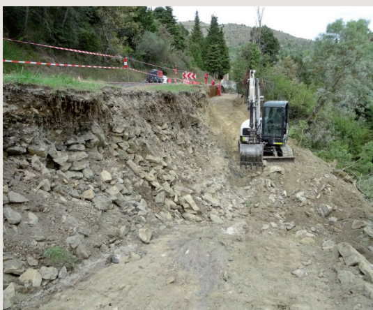
Les travaux menés sur la RD42 à Arquettes-en-Val, durant l'automne dernier, ont permis de renforcer la sécurité sur cet itinéraire.
