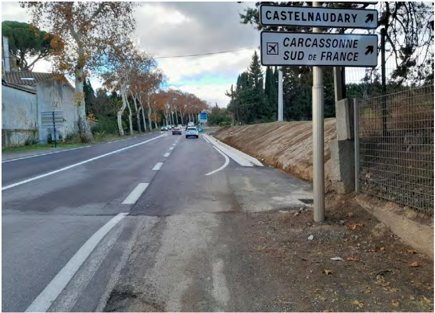
Nouvelle voie de by-pass pour les véhicules en provenance de Carcassonne et en direction de l'échangeur autoroutier de Carcassonne Ouest / Zone commerciale Planeto
