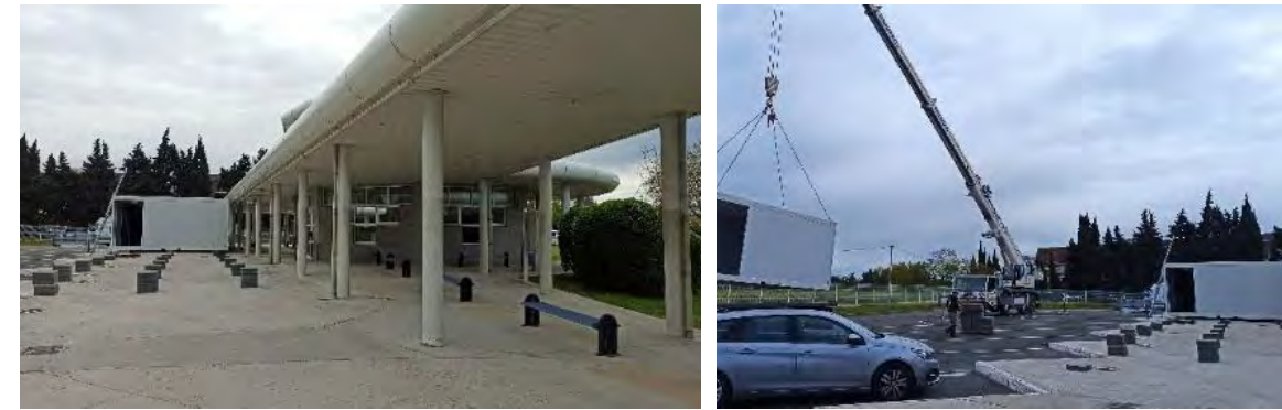
Installation des modulaires
