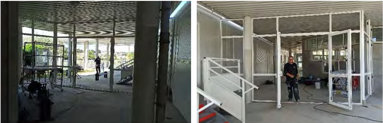
Travaux d'aménagement avec création du sas d'entrée et de liaison avec l'existant
