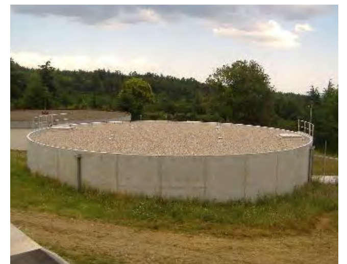
Usine de potabilisation des Barthes : décantation, traitement des boues et réservoir d'eau potable.
